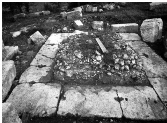
Fig. 46. Tomba a torre di Carsulae: particolare della fondazione e del nucleo interno del basamento (DONNINI 2018, fig. 11 e tav. II,1).
